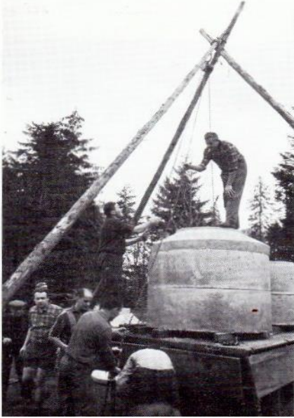
Bau der Klärgrube im September 1968
